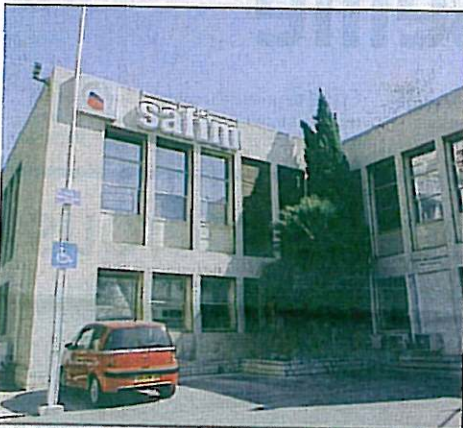
Le futur trois étoiles s'installera à la place des bureaux de la Safim, qui seront, eux, reconstruits à côté. / PHOTO KARINE VILLALONGA
