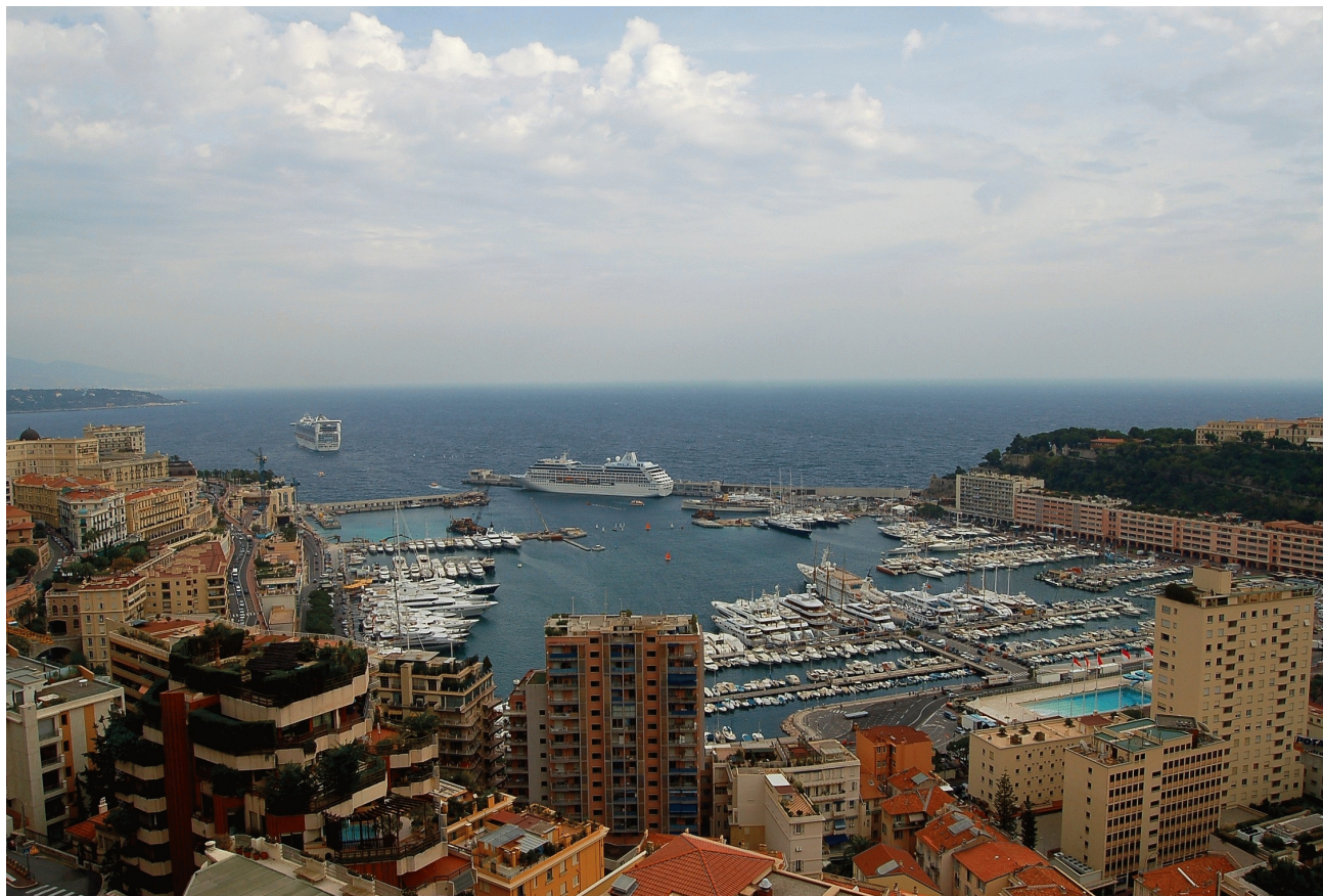
Figure 1 : Port de la Condamine, Principauté de Monaco. Les anciennes digues du port sont encore visibles à l'intérieur du bassin. La grande digue flottante est à droite de la photo (Ouest).
