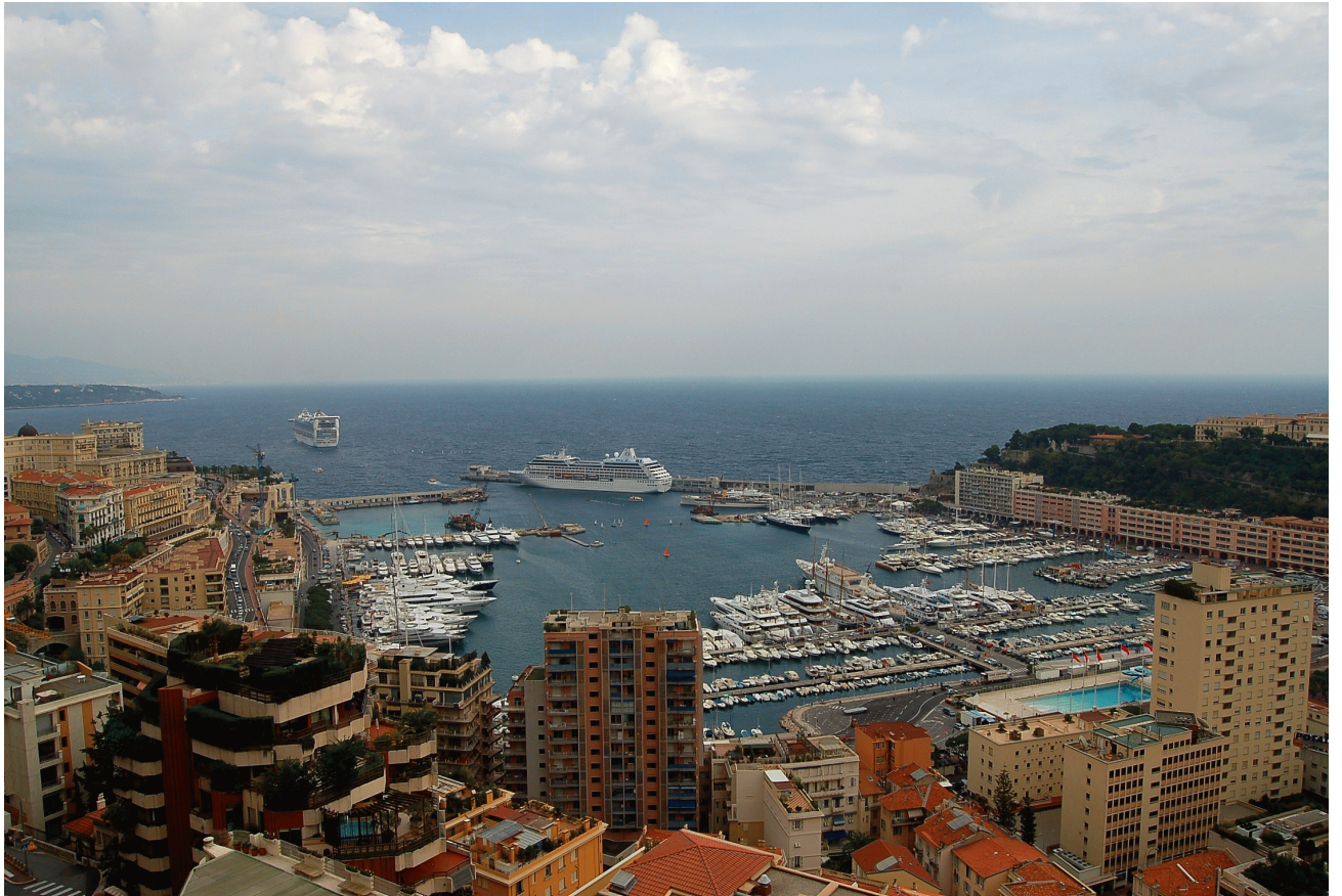
Figure 1 : Port de la Condamine, Principauté de Monaco. Les anciennes digues du port sont encore visibles à l'intérieur du bassin. La grande digue flottante est à droite de la photo (Ouest).
